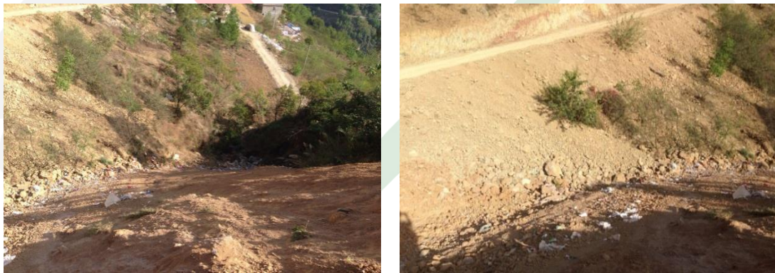
图九：梭山镇埡底村尤家沟社2号溪桥项目调研
