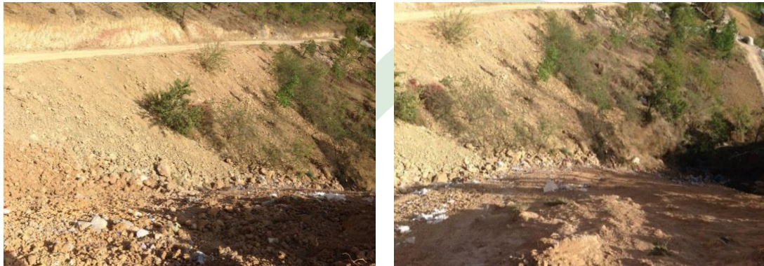
图八：梭山镇埡底村尤家沟社1号溪桥项目调研
