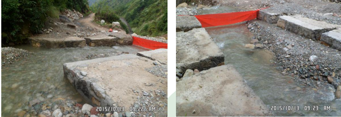
图三十三：梭山镇甘田村沟头社爱心桥基础施工
