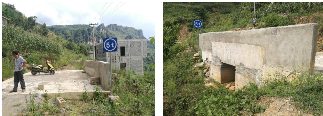
图四十二:梭山镇埂底村尤家沟 2 号桥主体基本完工
