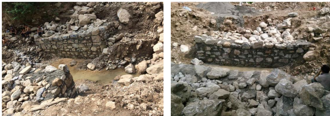
图三十六：梭山镇甘田村思茅坪爱心桥施工过半
