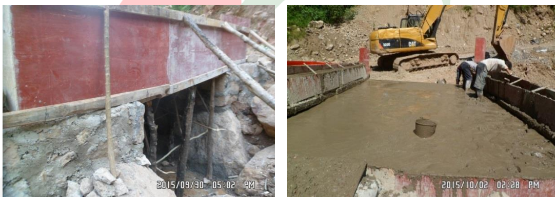
图三十七：梭山镇甘田村思茅坪爱心桥施工过半
