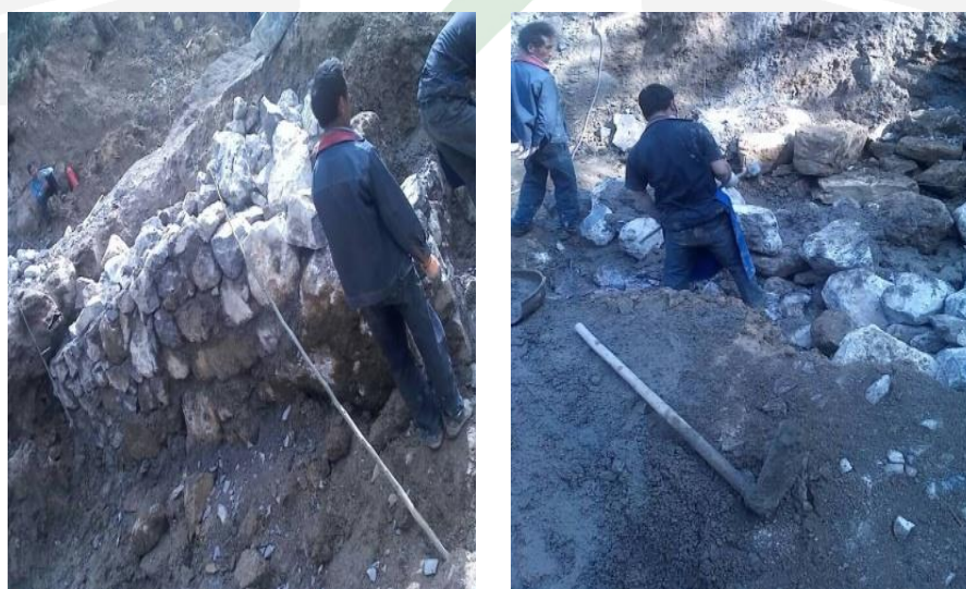
图二十：乐红镇红布村老火房爱心桥桥墩施工
