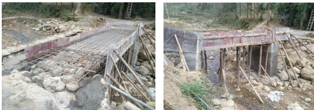
图二十七：乐红镇红布村肖家沟爱心桥桥面布筋浇筑
