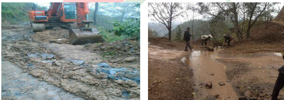
图十九：乐红镇红布村老火房爱心桥基础施工
