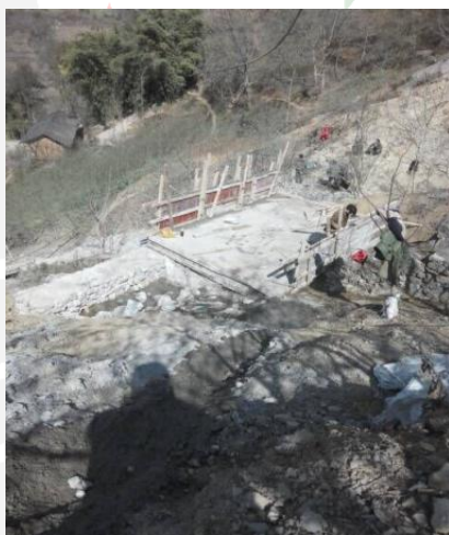
图三十一：乐红镇红布村小坝4号桥支砌挡墙
