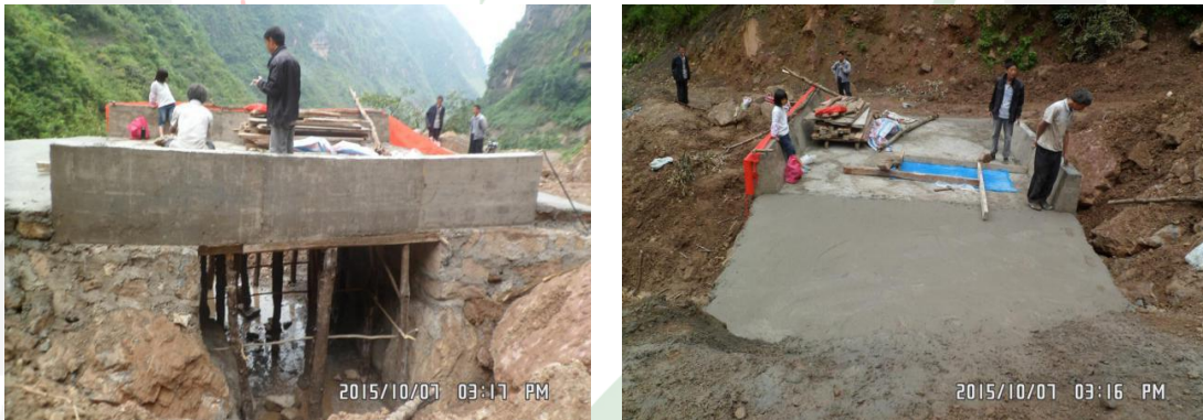
图三十四：梭山镇甘田村沟头社爱心桥施工过半
