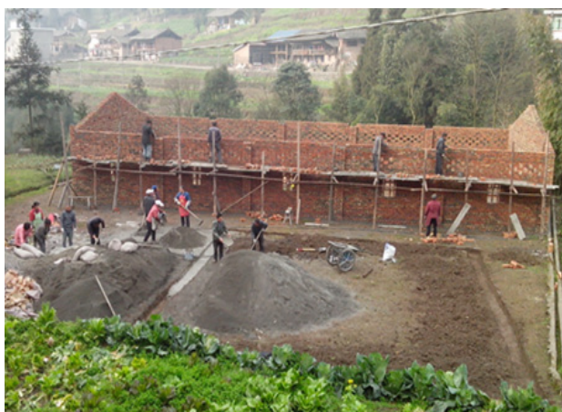
图1：围墙已基本竣工
